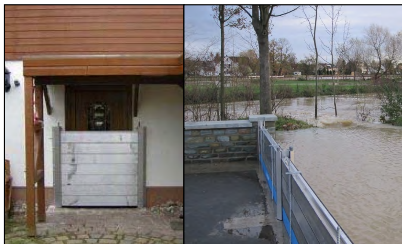
Dammbalkenverschluss Gebäude / Straße
