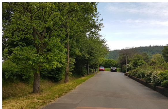
Zufahrt zum Plangebiet, rechts die angrenzenden Gärten
