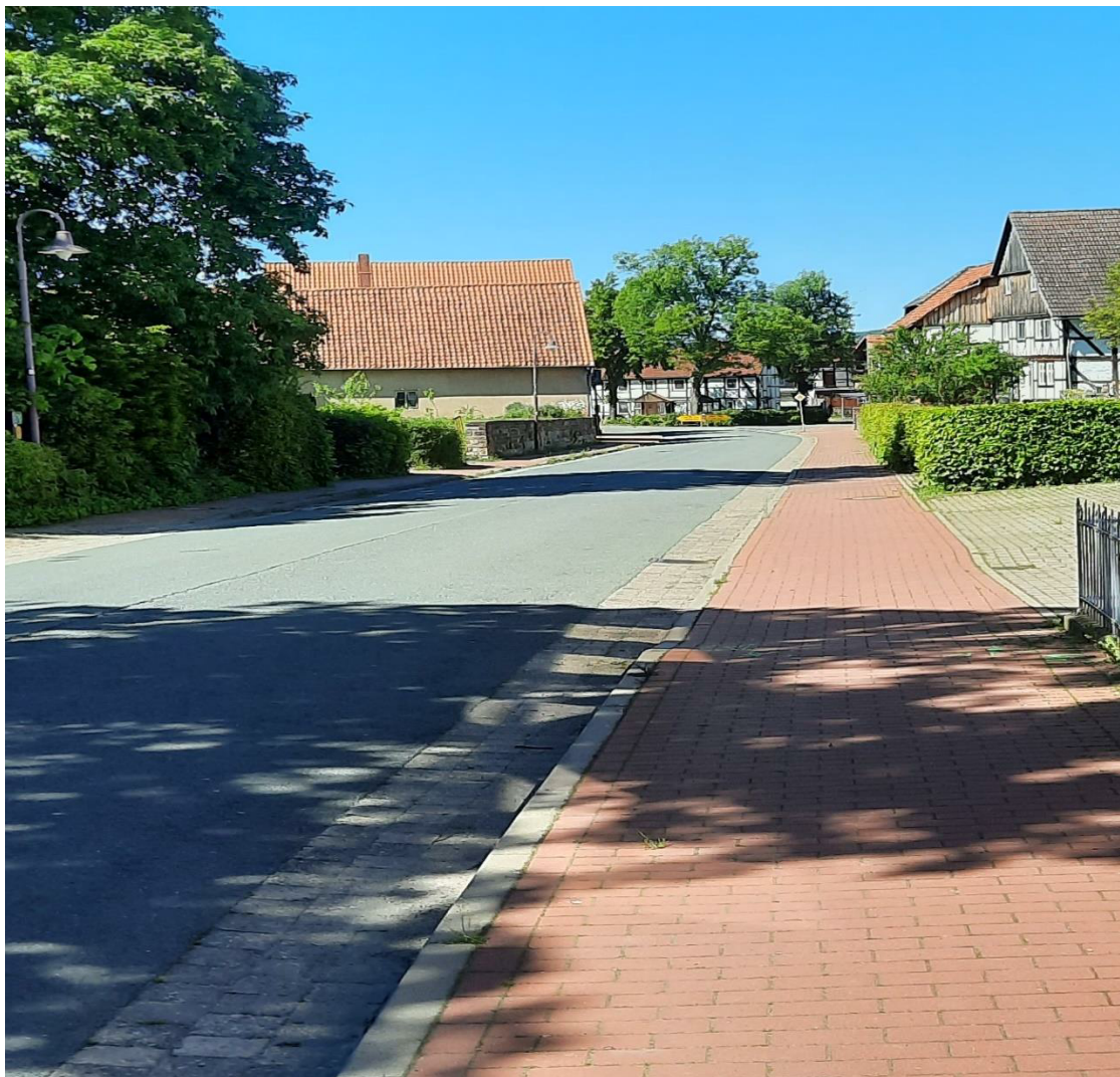
Neuer Gehweg Thingstraße in Hajen
