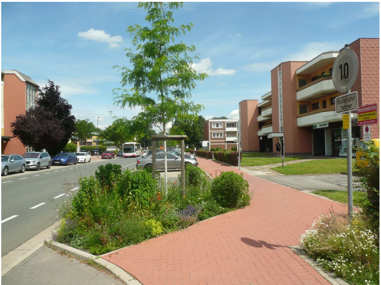
Berliner Straße nach der Sanierung
