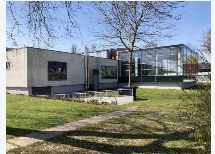
Sanierung des Vithalbads
