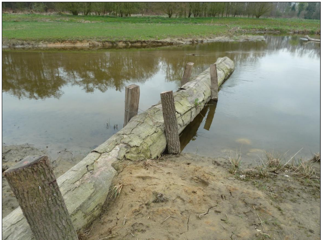
Abbildung 44: Totholzeinbau als Strömungslenker
