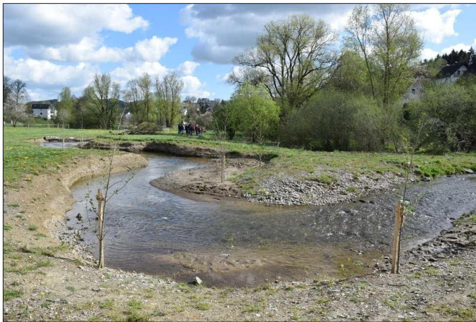
Abbildung 41: Neutrassierung mit natürlichem Querschnitt und Erleninitialpflanzung
