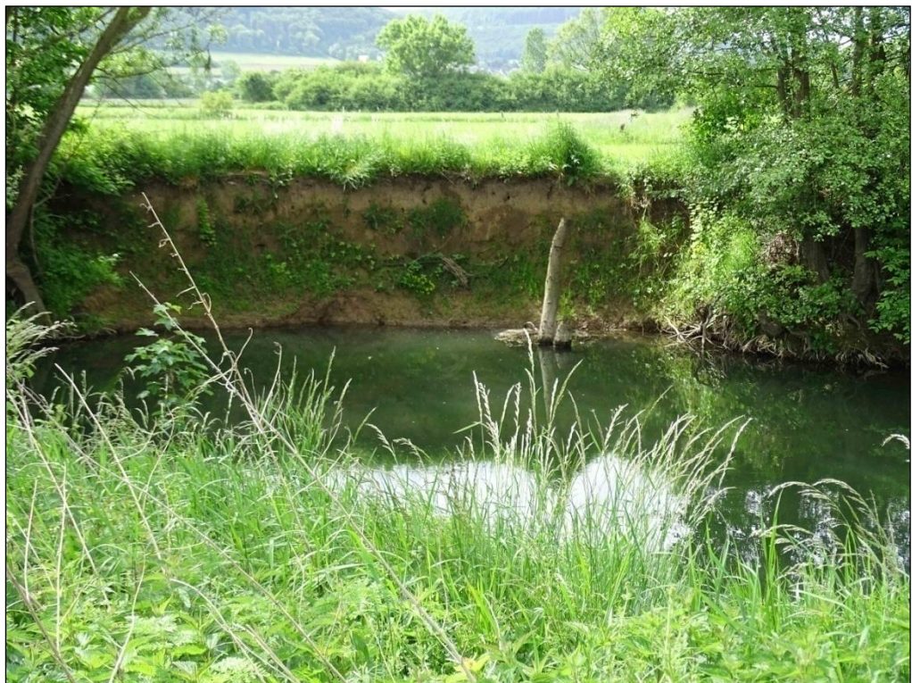
Abbildung 40: Steilufer nach Uferabbruch
