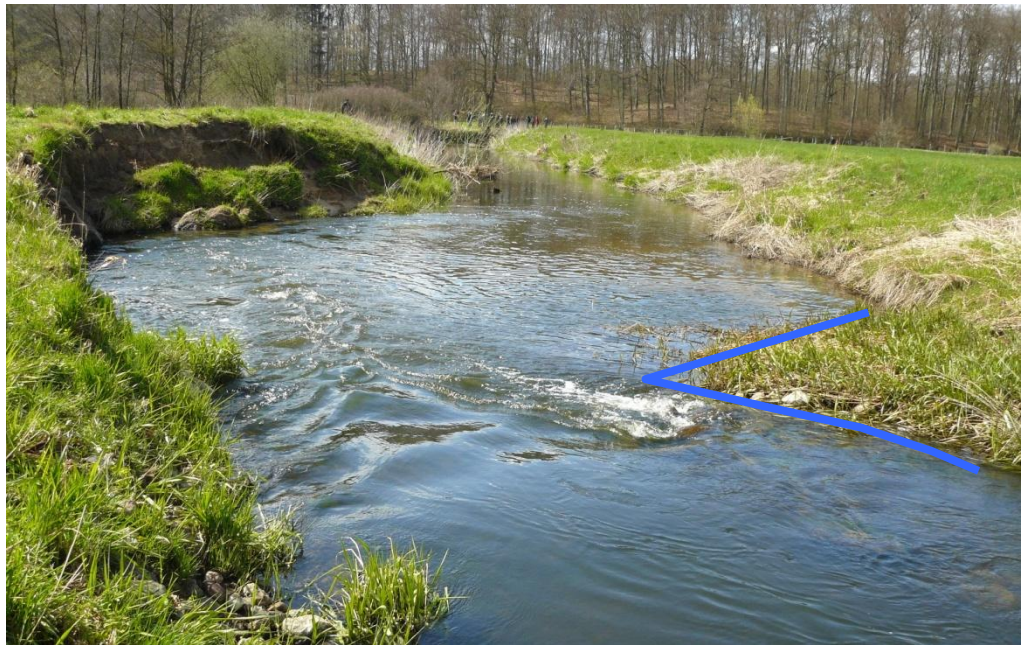
Abbildung 46: Ummöblieren: Einbau der alten Steinschüttungen des Uferverbaus als Strömungsenker
