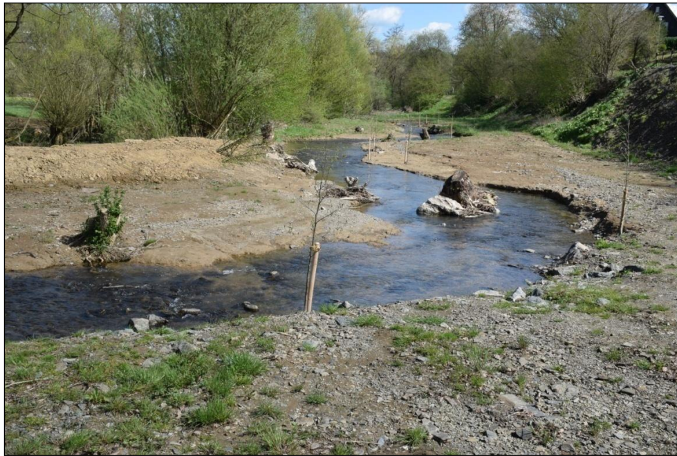
Abbildung 42: Neutrassierung mit Totholzeibau und Erleninitialpflanzung
