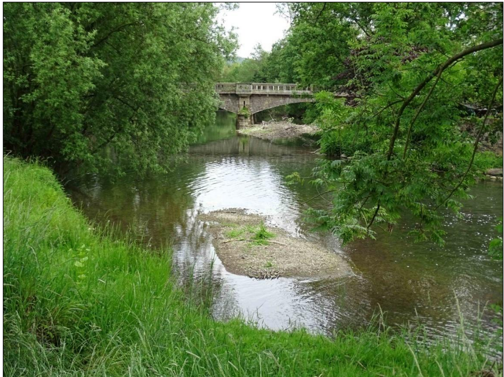
Abbildung 39: Anlandung einer Kiesinsel vor einem Brückenbauwerk
