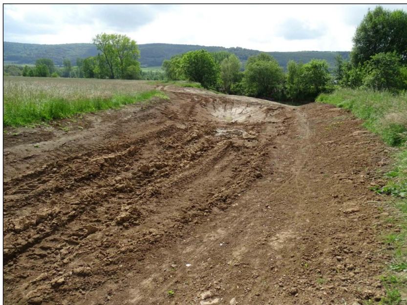
Abbildung 23: Senkenbereiche der Flutmulde im Bereich Tierpark Bad Pyrmont
