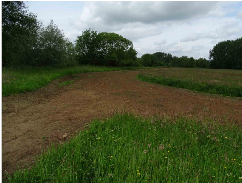
Abbildung 22: Flutmulde im Bereich Tierpark Bad Pyrmont
